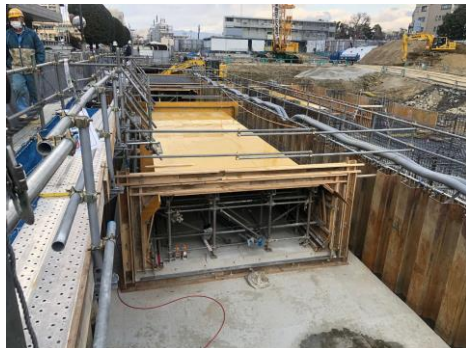
古い水路を撤去して新しい水路に改修しています。
