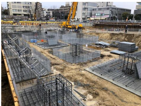
建物の基礎を設置しています。
