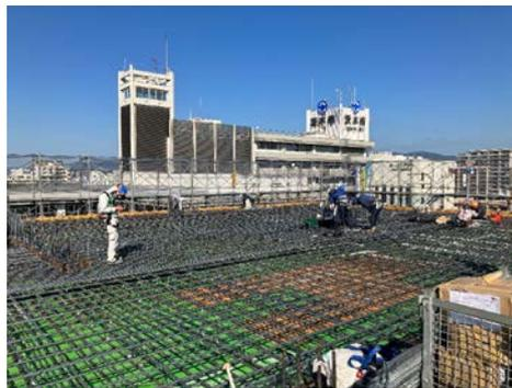
5階の床の鉄筋を組み立てています。
