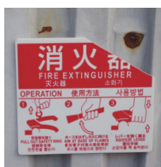
× 標識の破損
