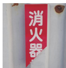
× 標識の破損
