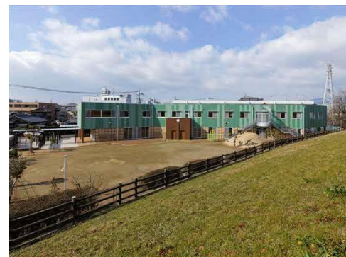
安威川土手からの写真
