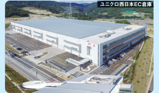
ユニクロ西日本EC倉庫
