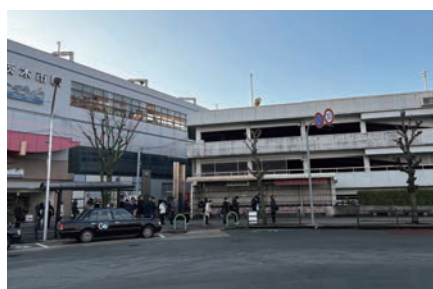
阪急茨木市駅前西口駐車場（永代町）
