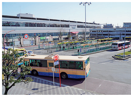
阪急茨木市駅西口周辺（永代町）
