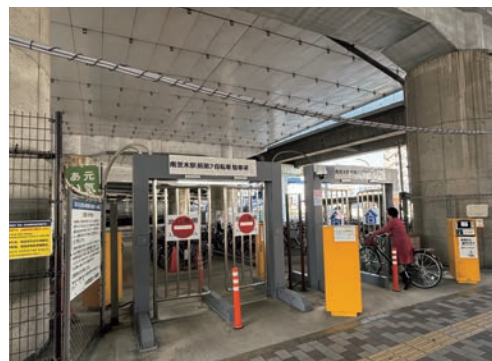
南茨木駅前第2自転車駐車場(東奈良三丁目)
