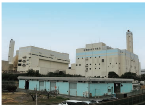
ごみ処理施設 環境衛生センター(東野々宮町)
