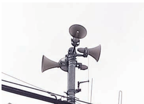
大池小学校の屋外スピーカー
