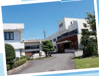
十日市浄水場
