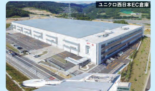
ユニクロ西日本EC倉庫
