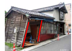
外壁が大きく傾斜しており、建具や窓枠がはずれ、原型を留めていない
