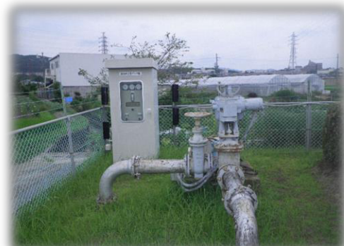
十日市浄水場 第3号取水井
