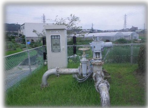
十日市浄水場 第3号取水井
