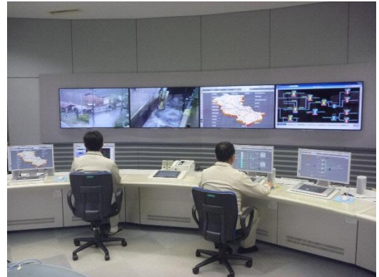
十日市浄水場中央監視室
