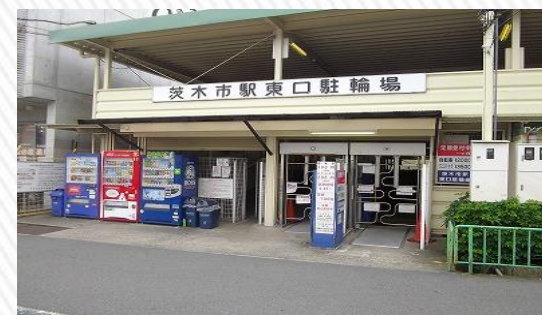
茨木市駅東口駐輪場
