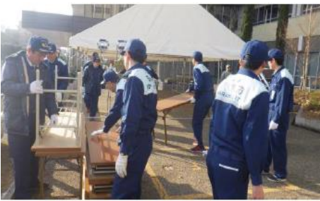
仮設災害対策本部テント設営
