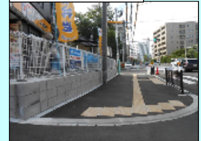
A6 総持寺駅前線・歩道整備
